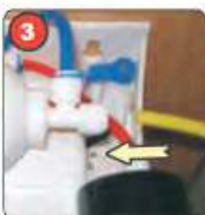
3 INSERTAR TUBO HASTA EL FONDO
