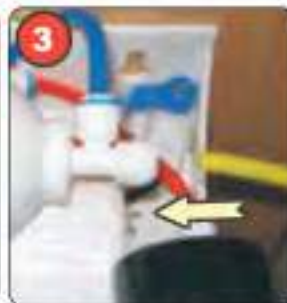
3 INSERTAR TUBO HASTA EL FONDO
