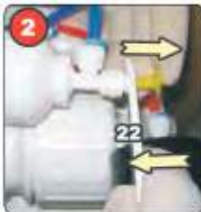
2 PRESIONAR CON LLAVE Y SACAR TAPÓN
