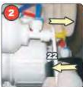
2 PRESIONAR CON LLAVE Y SACAR TAPÓN
